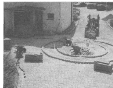
Pflasterer bei der Arbeit
